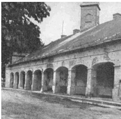
A kastély hátsó homlokzatán hosszú tornác nyílt
